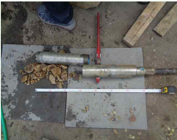
TYPE2(STA.0+32) 용벽 상부 지반상태 확인
