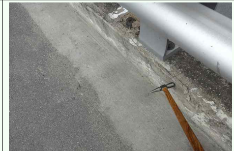
사진8 -S1 방호벽 연석 틀뜸
