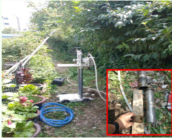
TYPE2(STA.0+60) 용벽 상부 지반상태 확인
